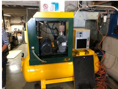
ООО «Агат», замена винтового блока
