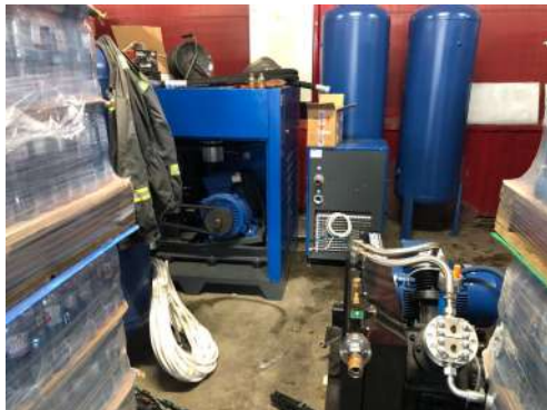
«Форштадтская пивоварня», монтаж пневмолинии для выдува ПЭТ
