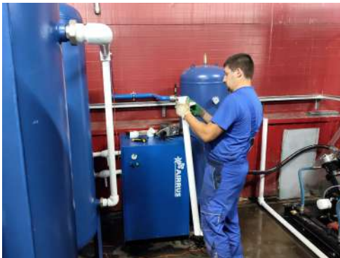
«Форштадтская пивоварня», монтаж пневмолинии для выдува ПЭТ
