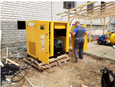
ИП Дедов А.В, пусконаладка компрессора для транспортировки цементного раствора
